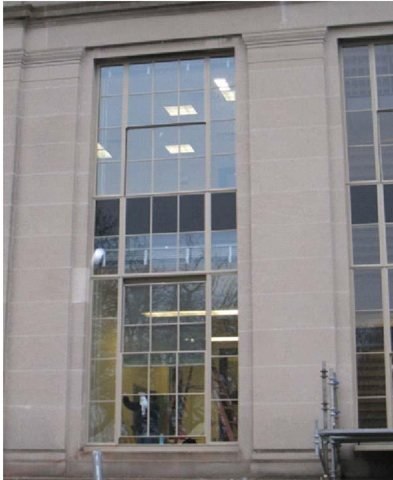
Fig. 10 MIT Boston. Exterior detail
